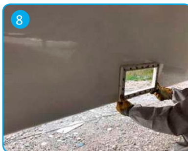
8 Acabado final y control de calidad Finishing and quality control
