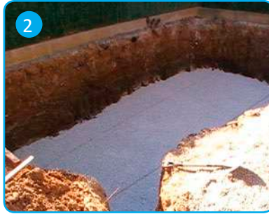
Preparación del terreno Ground preparing
