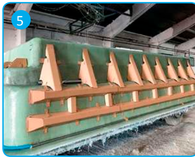
5 Colocación de refuerzos verticales y horizontales y hierro galvanizado para la obtencion de una mayor dureza y resistencia al impacto Placement vertical and horizontal reinforcements and galvanized iron for obtaining higher hardness and resistance to the impact
