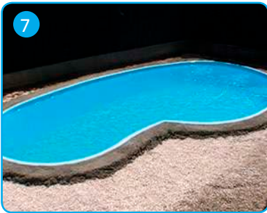
Asientos de brocales Coping stone placing
