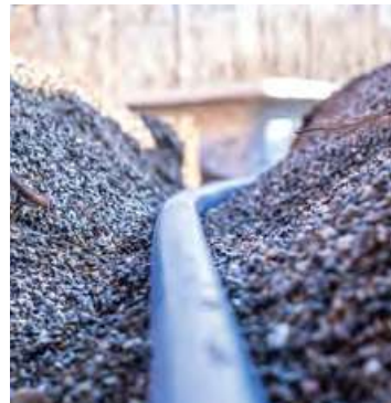
06. Instalación de tuberías
