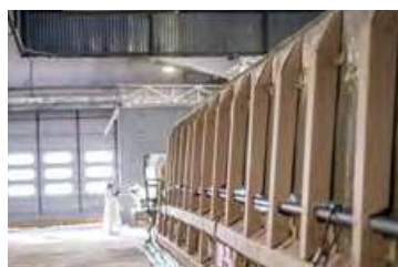
05. Colocación de refuerzos verticales y horizontales
