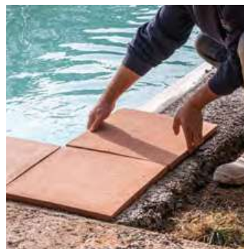
08. Colocación del borde perimetral
