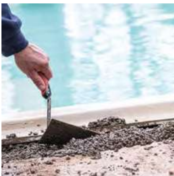
07. Relleno de la solera con cemento para la colocación de los bordes
