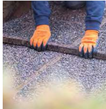
02. Preparación de la base con una solera de grava
