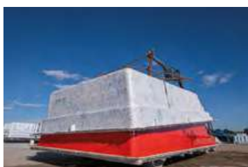
07. Desmoldado de la piscina
