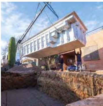
03. Colocación de la piscina en el agujero
