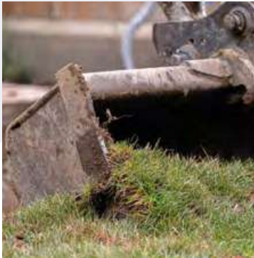
01. Excavación de la superficie de tierra
