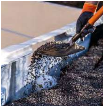
05. Rellenado de los laterales con grava
